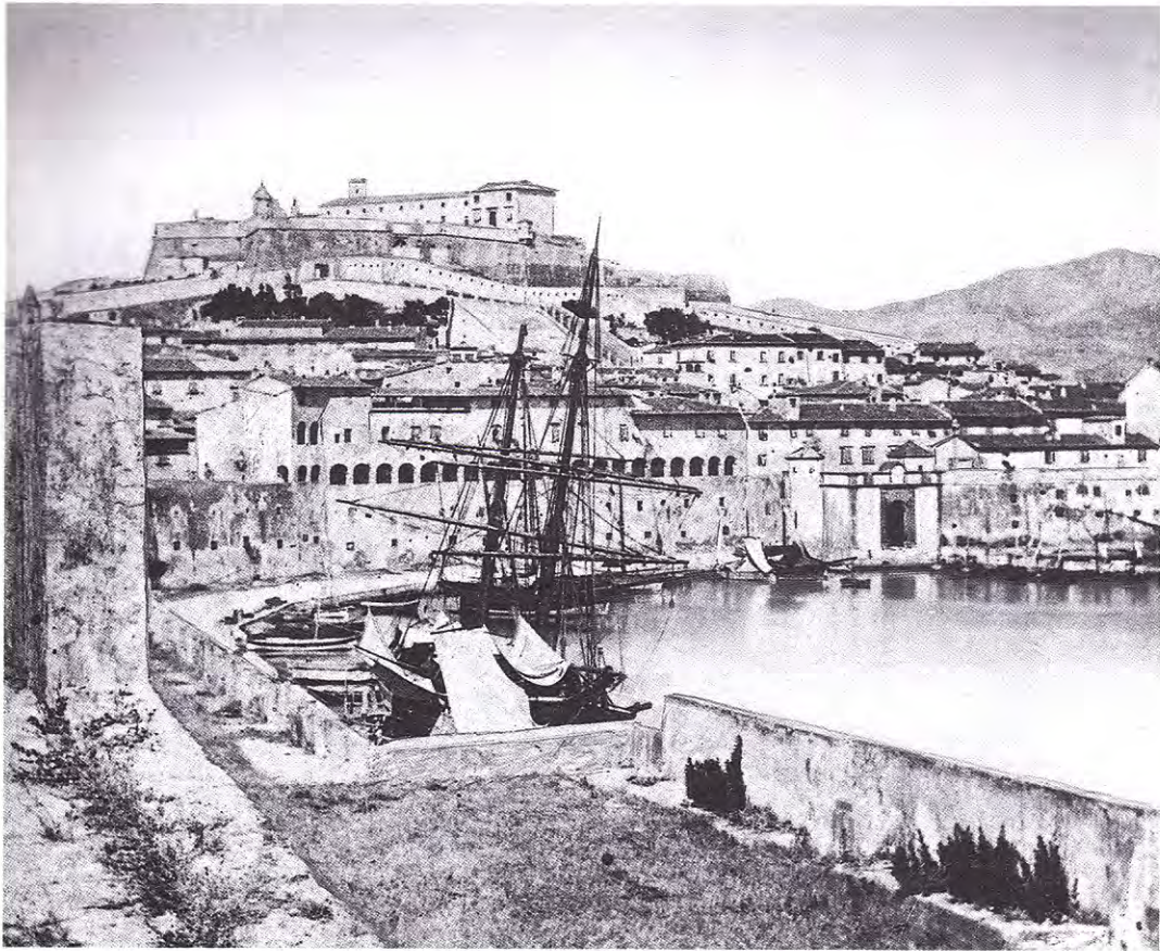
Fig. 10. PORTOFERRAIO, INTERNO DEL PORTO VISTO DAL CORNACCHINO.
