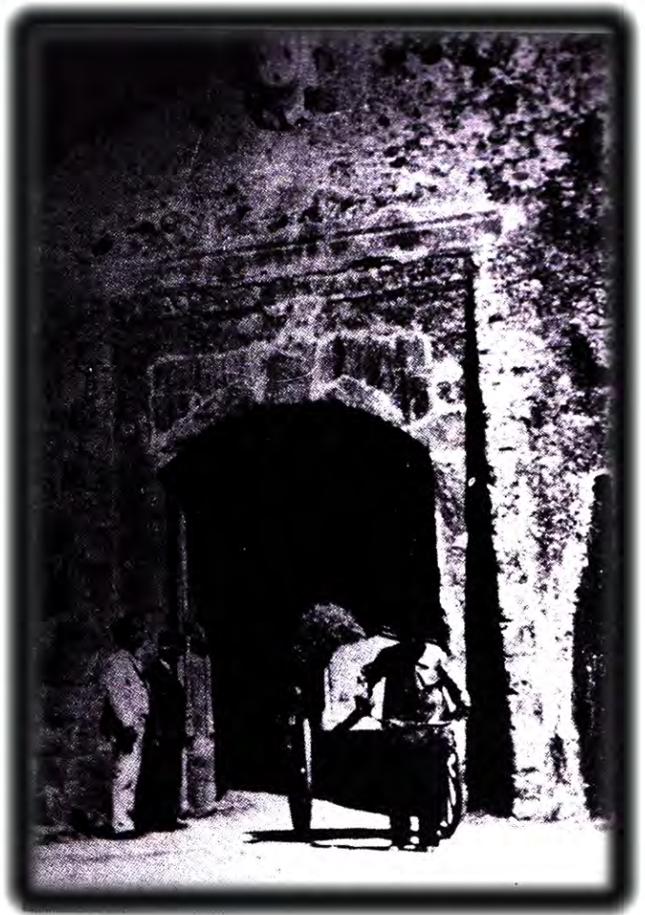
Fig. 13. PORTOFERRAIO, LA PORTA A TERRA VERSO IL PONTICELLO.
